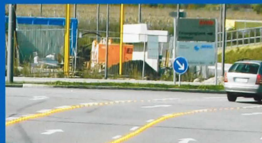
LaneLight: Verkehrslenkung beim Fußballstadion in München/Deutschland
